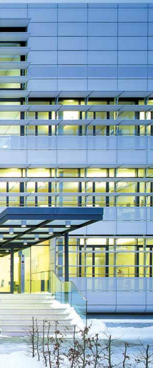
Obr. vľavo dole iHome Lab, Luzern, Švajčiarsko - vonkajší plášť budovy má vytvárať rybie žiabre. Tvoria ju vertikálne lamely z ocele. Celkovo je osadených 380 pevných a 300 pohyblivých prvkov, ktoré vytvárajú hlboký dojem.
